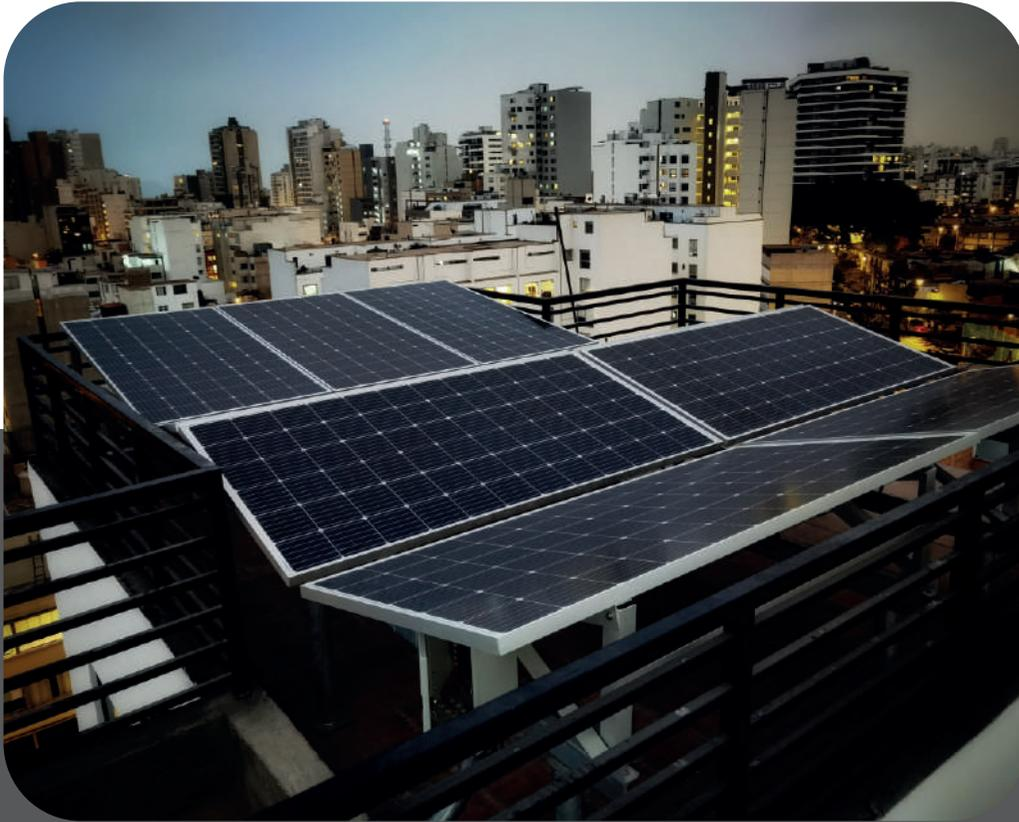
Sistema Fotovoltaico Híbrido de 8.2kWp
